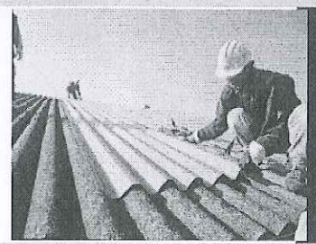
REPARACION Y ARREGLO DE COBERTURAS LIVIANAS
