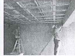
REPARACION DE FALSO CIELO RASO
