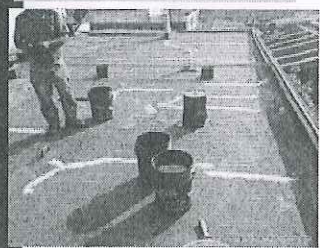
SELLADO DE PERFORACIONES E IMPERMEABILIZACIONES
