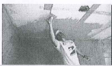
TARRAJEO, ENLUCIDO DEL CIELO RASO EN LOSA ALIGERADA
